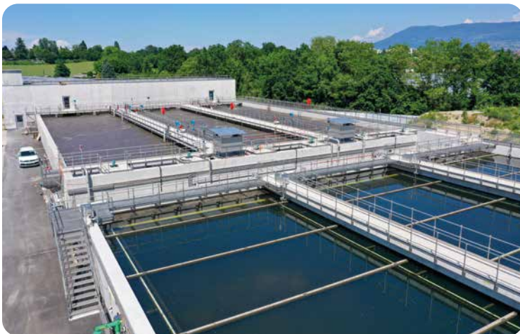
Villette WWTP (Thônex) © SIG
