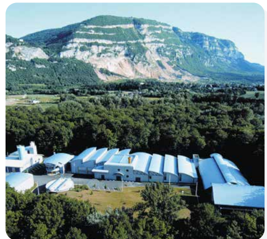
Ocybèle WWTP (Annemasse) © Annemasse Agglo
